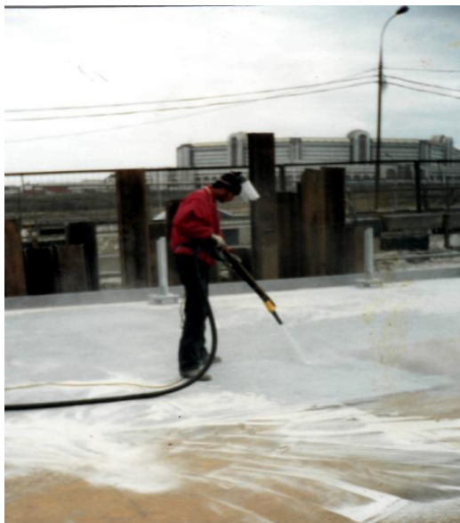
Рисунок 4 - Струйно-абразивная обработка поверхности ортотропной плиты
