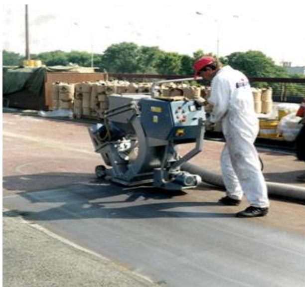
Рисунок 5 - Дробеструйная очистка поверхности металла аппаратом
