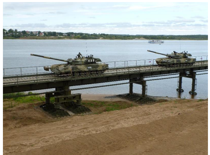
Устройство покрытия колейных проходов на ИМЖ- 500 (сборный танковый и ж/д мост)
