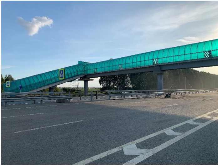
Надземный пешеходный переход, г. Москва.
