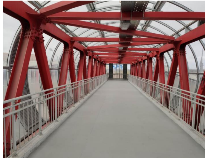
Пешеходный мост, Московская обл.
